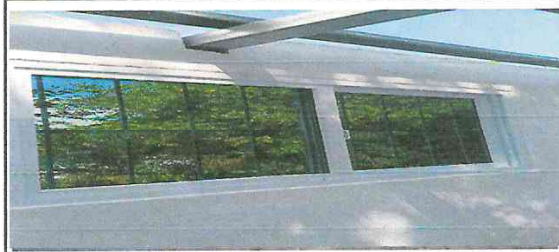
Foto 4: Instalación de ventanas de PVC.
