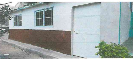
Foto 5: Instalación de puerta de metal.
