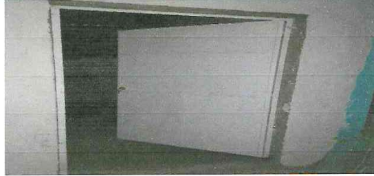
Foto 1: Sustrucción de puerta de metal.
