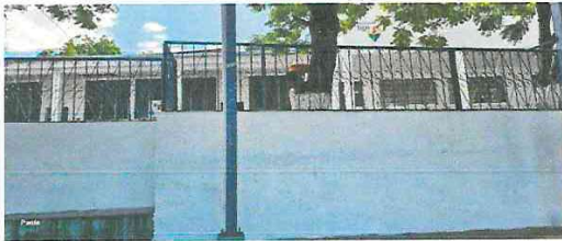
Foto 3: Reparación de bordio y salida de agua en área de cancha.
