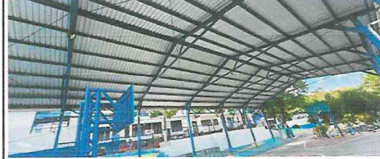
Foto 2: Reparación del sistema eléctrico y alumbrado en área de cancha.
